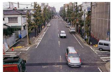
現在の鋼管通
